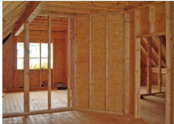
Abbildung 5: Mit Kiefer ausgebautes Dach eines Wohnhauses (Foto: Klenk AG, Oberrot)
